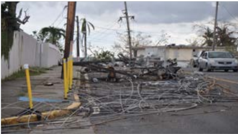
Figura 1. Imagen de la destrucción provocada por el huracán María.
